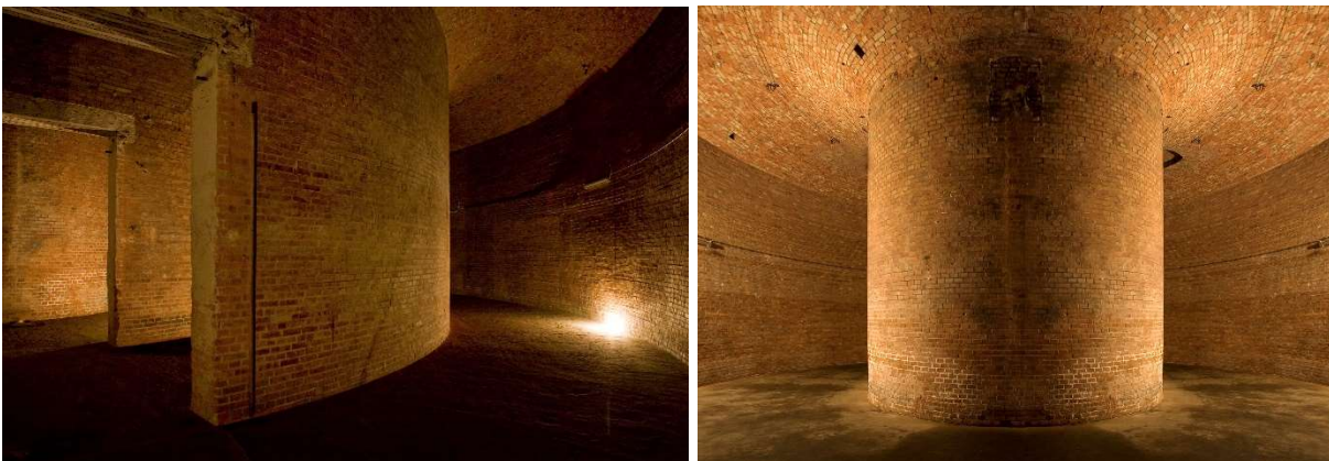
Großer Wasserspeicher_Fotos: Roman März
